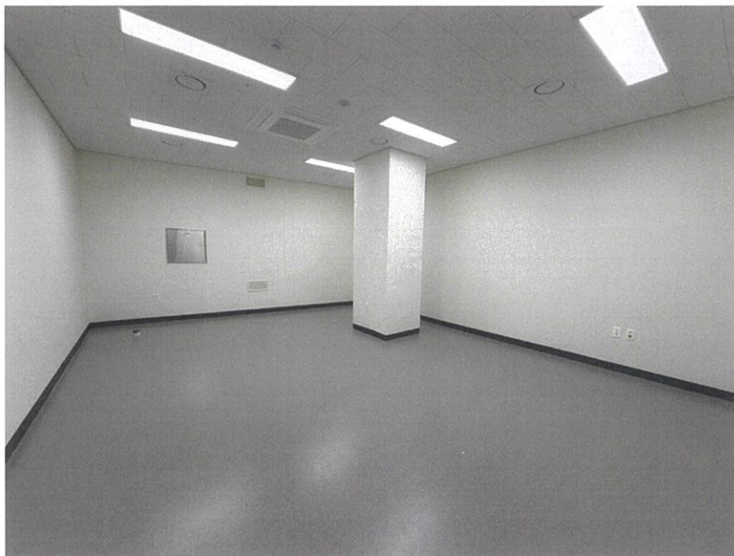
[ 일련번호(12) 내부 전경 ]
